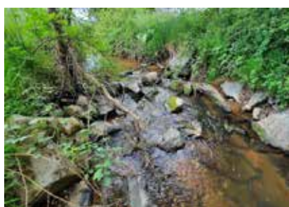
Figure 1 : exemple d'ouvrage en pierres qui stabilise le fond de la Schernetz (photo : SINBIO SCOP, 2022)
